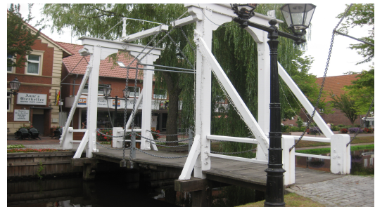
Brücke über dem Hauptkanal
