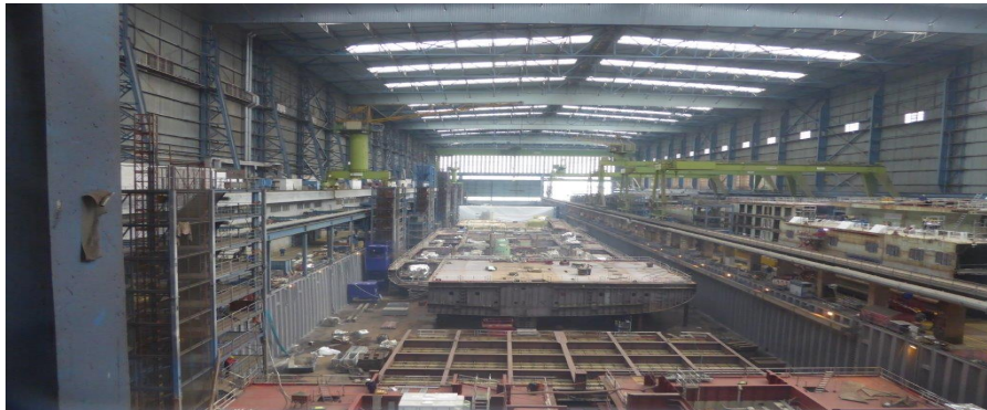
Innenansicht des größten Baudocks der Welt
